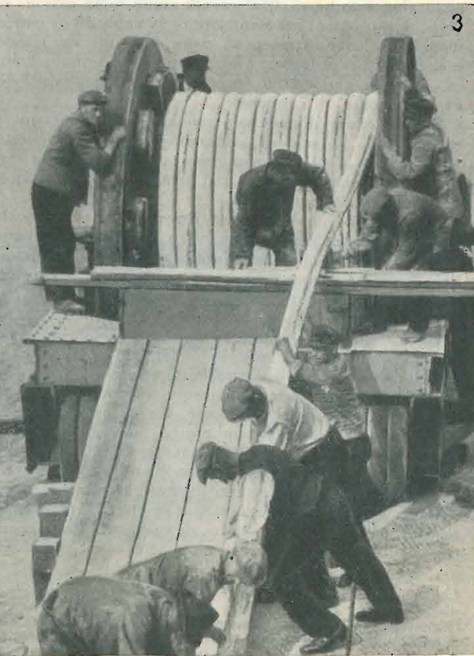
3. La posa in opera di un cavo in piombo per alte tensioni.
